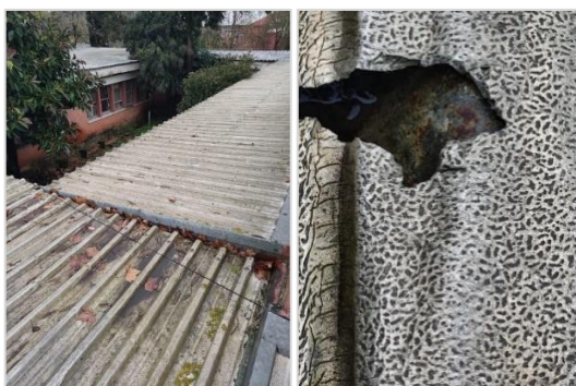
Pormenores da cobertura do Palácio da Justiça de Rio Maior
